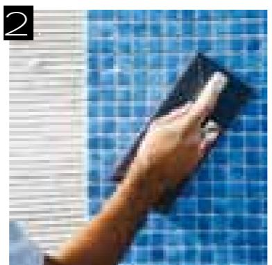
Colocar los paneles con el sistema de puntos **JointPoint®** y aplicarlos sobre la superficie.
