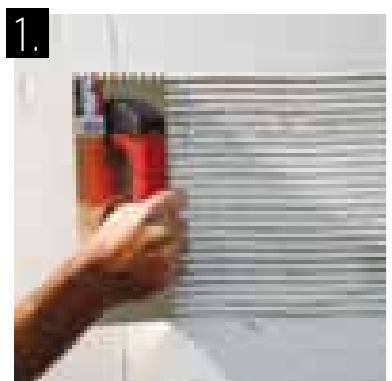
El amasado de la cola se realizará siguiendo las recomendaciones del fabricante. Extendiendo la masa con una llana dentada de 6mm de la manera más homogénea posible.
