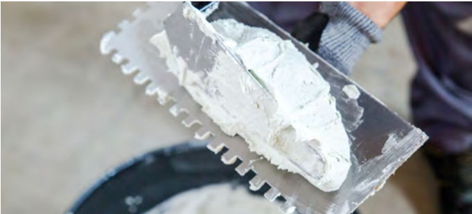
Spread the adhesive cement with a toothed trowel | Extiende el cemento de agarre con una llanta dentada | Étendre le ciment à prise rapide à l'aide d'une spatule dentée | Verstreichen Sie den Klebemörtel mit einem Zahnsachtel
