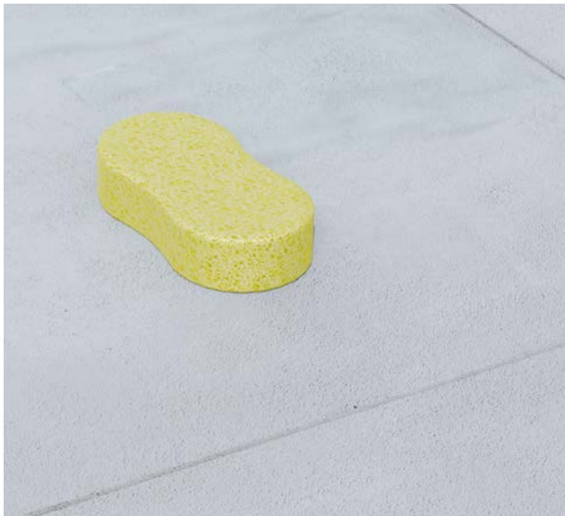
Oberfläche reinigen und entfetten
