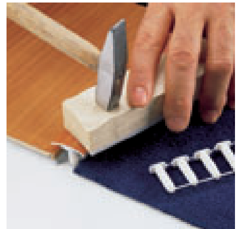
Befestigung des Profils, wie abgebildet, mittels eines Hammers und Holzstückes
