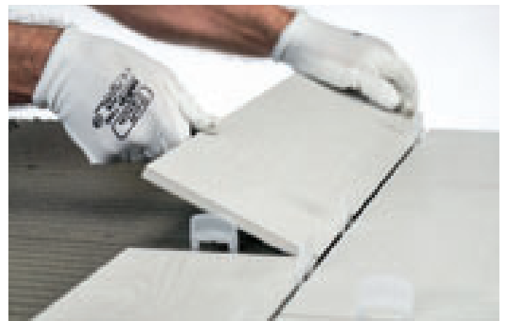
Verlegung der Fliese
