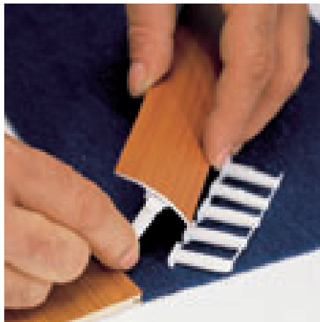
Einschieben der Dübel in die Führungsnut und Fixierung der Dübel entsprechend der Bohrungen
